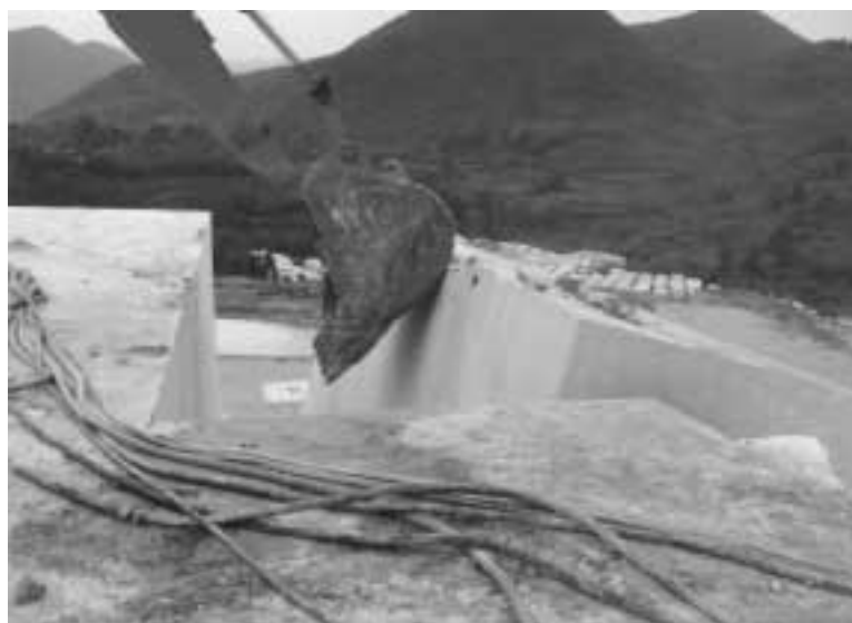
圖8.10 用挖掘機翻轉大塊長方形石
