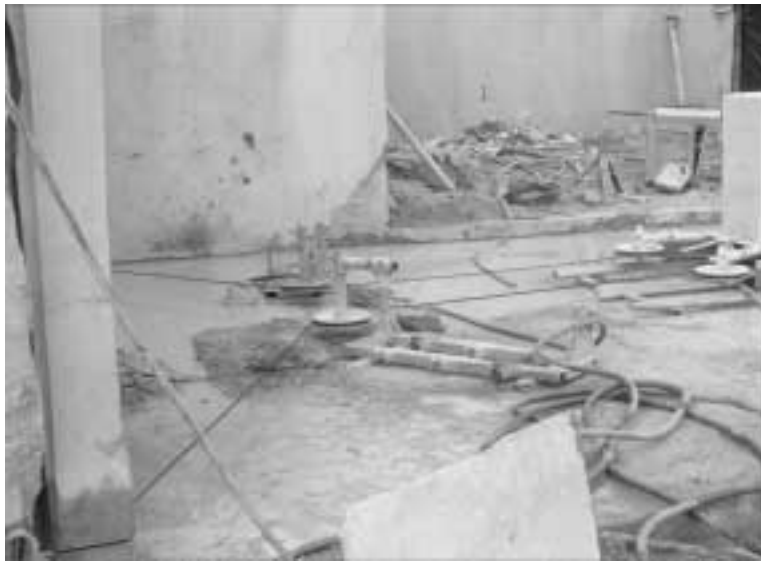
圖8.6 用金剛石帶鋸切割機作橫向切割
